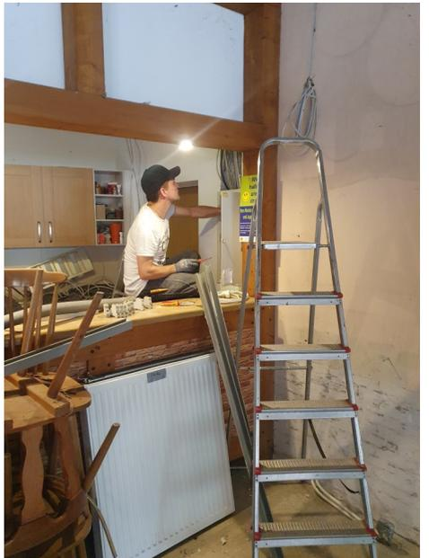
Die Heizungsrohre werden befestigt und die elektrische Verkabelung wird überarbeitet. Und—die Damen können sich in Zukunft mit warmem Wasser die Hände auf dem WC waschen.
